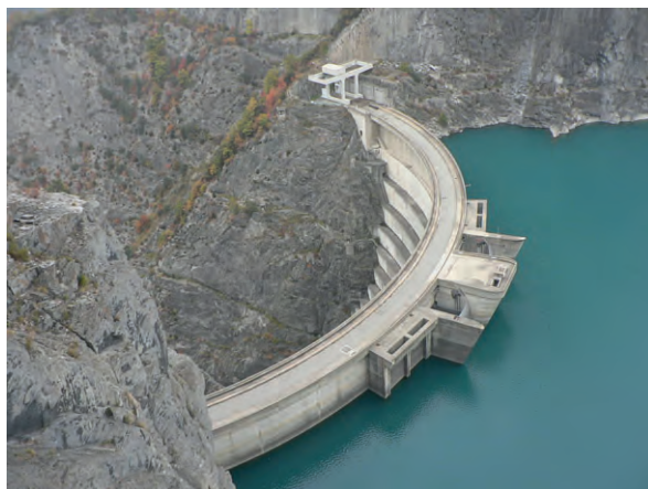
Barrage de Monteynard (Isère, France)
